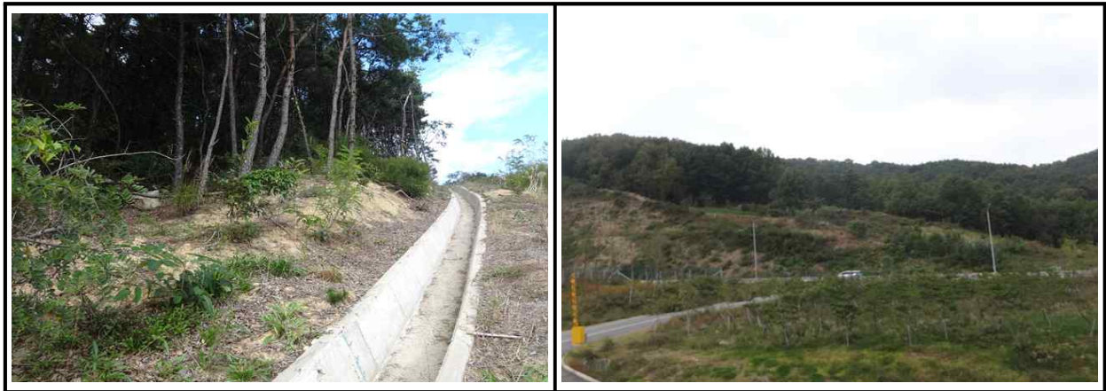
【그림 3.3.1】 상부자연사면 전경
