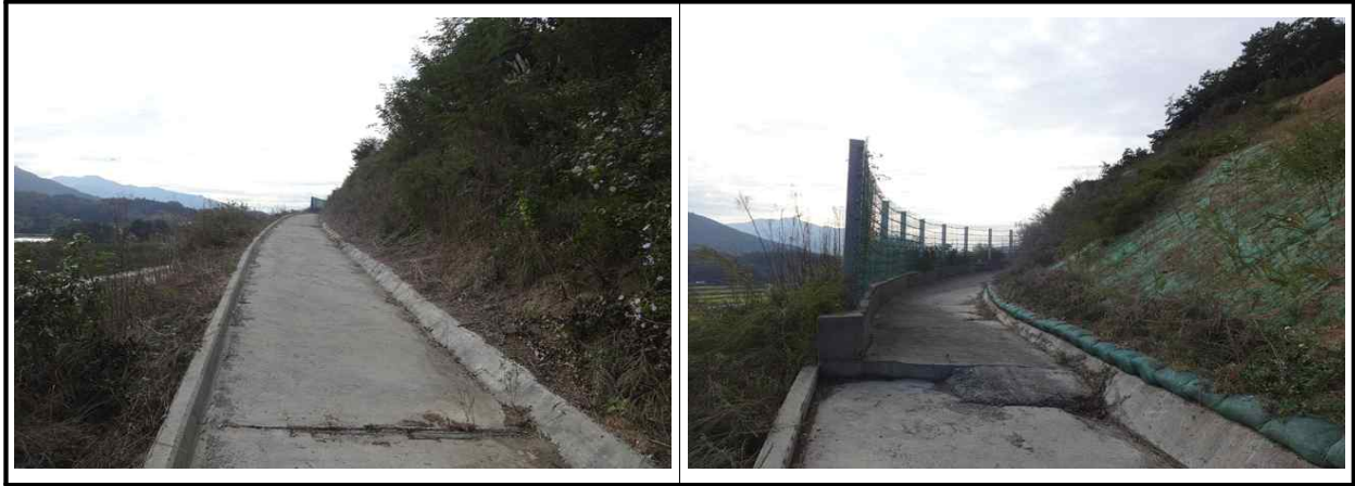
【그림 3.3.3】 배수시설 전경
